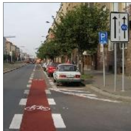
Fotografie 26: Je patrné, že střed pruhu je více vlevo, než se zdá při jízdě podél parkujících aut (PC)
