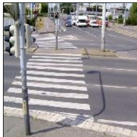
Fotografie 12: Příjemný přechod pro chodce je chráněný světly a má nízké obrubníky (foto vř).
