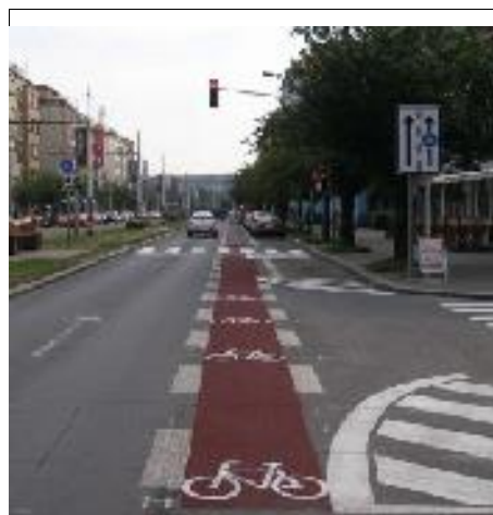
Fotografie 24: Pruh prochází plynule skrz křižovatku, cyklostezka by byla přerušena přechodem nebo přejezdem s nutností dávat přednost (foto pc).
